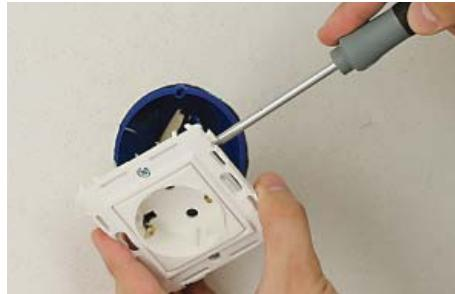
Подсоедините провода к розетке. Установите собранное изделие в коробку (диаметр коробки 65-68 мм, глубина более 40 мм)
