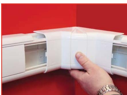
Установите накладку угла и крышки кабель-канала
