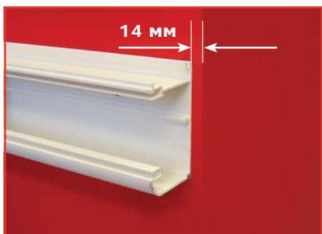
Закрепите кабель-канал на расстоянии 14 мм от угла стены (используйте базу угла как шаблон)
