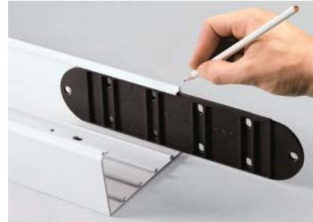
При монтаже коробов "In-Liner" и "In-Liner FRONT" на консолях или на стене необходимо закрепить соединитель GTA-SN полиамидными винтами (идут в комплекте)
