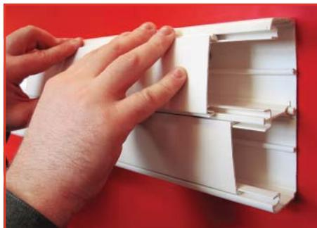
В короб 140x50 мм установите несущий разделитель (код 01412) и 2 крышки шириной 60 мм
