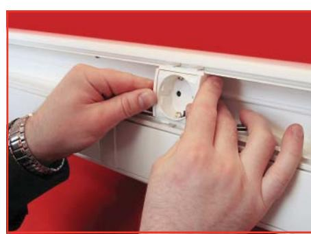
Защелкиванием установите каркас с электроустановочным изделием в короб
