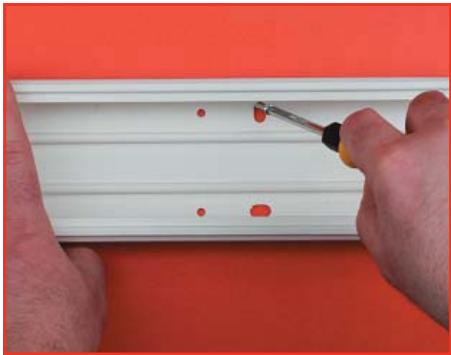
Короб крепится к стене на винтах-саморезах (крепеж см. в разделе "M5 Combitech") через перфорацию на основании
