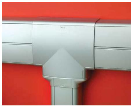
Защелкиванием установите накладку на тройник. Затем крышки коробов сдвиньте в сторону тройника или переустановите их заново, чтобы они зашли под накладку.
