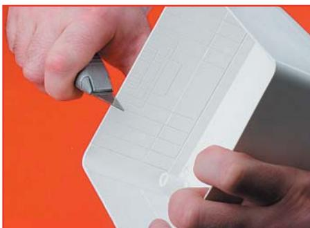
Вырежьте в крышке коробки по перфорации проемы под соответствующий размер канала
